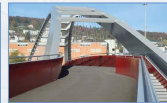
Gleisbogen Bridge, Zurich (Monopol Colors)
